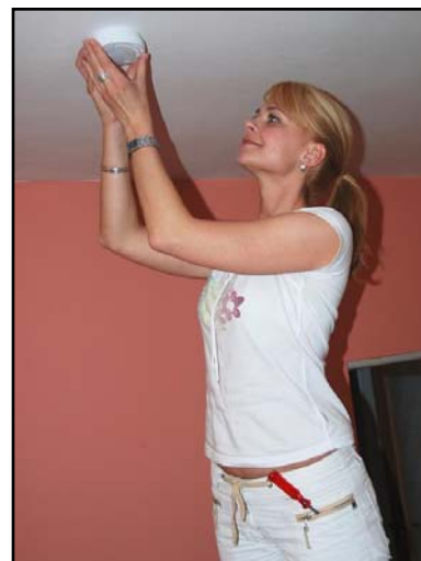
Obr.: Instalace hlásiče kouře
