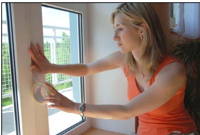
Obr.: Utěsnění oken lepicí páskou
