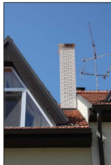
Obr. Kontrola komínu
