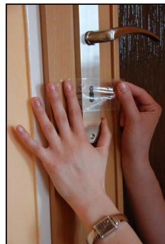
Obr.: Utěsnění klíčové dírky
